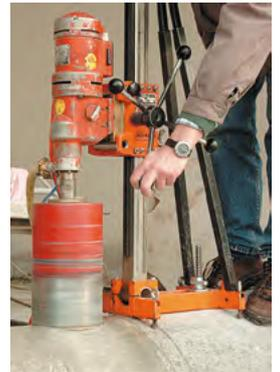
2. Bohrlochwandung – sofern trocken – vollflächig und kräftig mit Wasser befeuchten. Feuchte kurz einziehen lassen, bis eventuelle Tropfnässe verschwindet).
