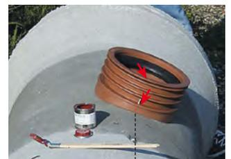
4. Vor der Montage der Anschlussleitung sind der Dichtring in der Muffe des Stutzens und die Rohrspitze der Anschlussleitung mit **DS BAST GV** zu versehen. Bei einem abgeschnittenen Rohr muss die Spitze für die Montage angefast werden.
