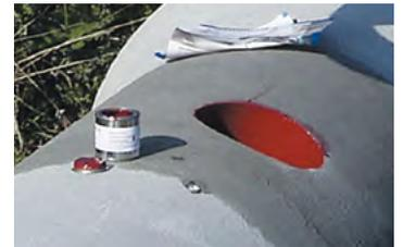
3. Bohranschlussstutzen zentrisch mit Markierung in Achsenrichtung des Betonrohres bis zum Anschlag in die Bohrung eindrücken. Das zentrische Ansetzen ist wichtig, damit die erste Rippe der Gummimanschette gleichmäßig verpresst wird und nicht umschlägt.
